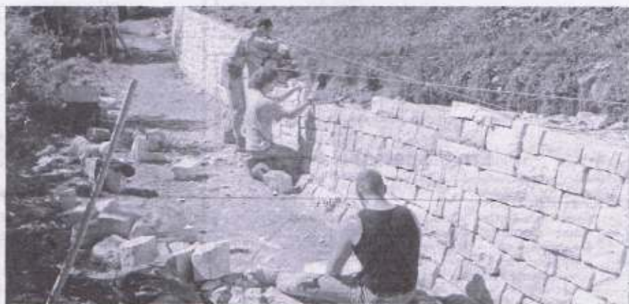
Der Bau der Trockenmauer in Sulz wurde durch die Stiftung proFricktal unterstützt.
